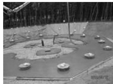
図2 風力発電施設基礎工事での実用化
