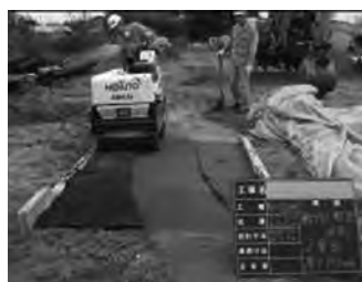
写真2 路盤の試験施工
