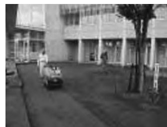
写真3 科学技術棟オープンテラス地盤改良工事
