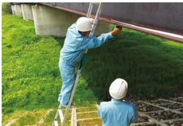
卒業研究(橋梁桁下の腐食量調査)
