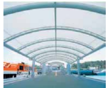
図1 円弧型骨組膜構造独立上屋の例（沖縄県黒島港）
