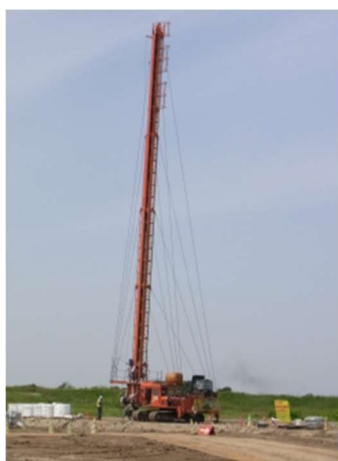
図 1 PBD の打設状況
